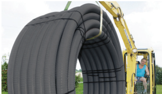
Fig. 40 Løft med gravemaskine
