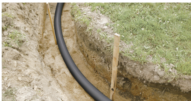
Fig. 47 Lægning af rør i bøjet område
