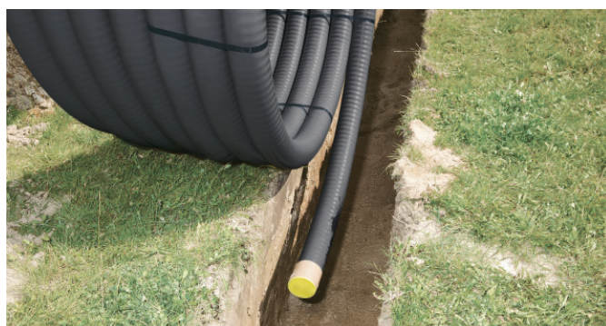
Fig. 45 Åbning af ringbundet lag for lag
