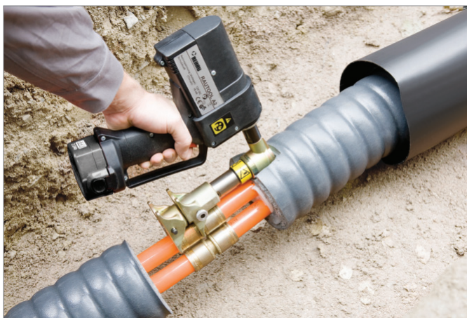
Fig. 2 RAUVITHERM muffeforbindelse
